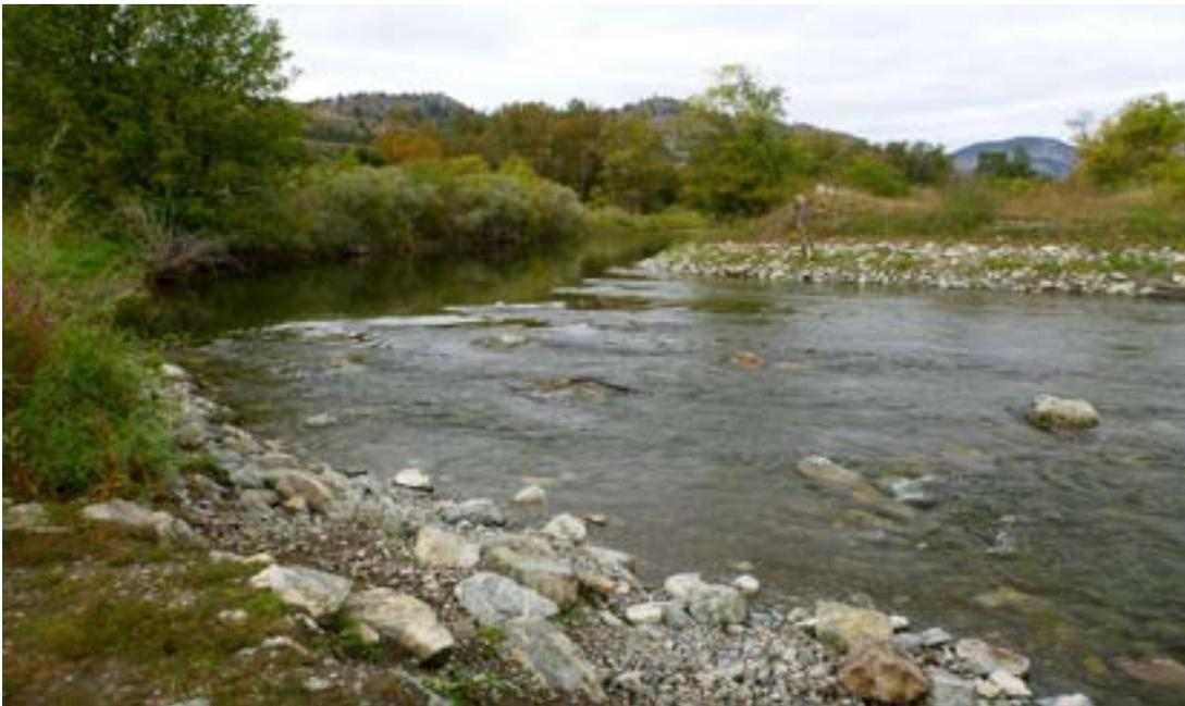
Figure 25. Exemple de seuil de type Newbury
