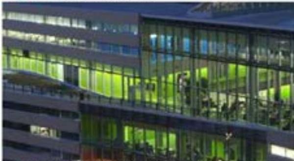
Image 42. Vitrages à haut rendement énergétique (S1 à S7. [www.lemiro.com](http://www.lemiro.com))
