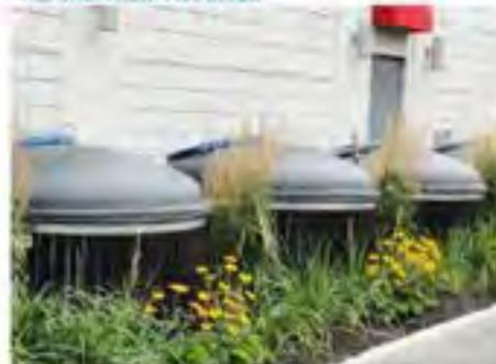
Image 82. Conteneurs semi-enterrés intégrés aux sites industriels (3. [www.bleu-bleu.com](http://www.bleu-bleu.com))
