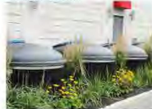
Image 88. Conteneurs semi-enterrés intégrés aux sites industriels (S. Indéterminée-Internet)
