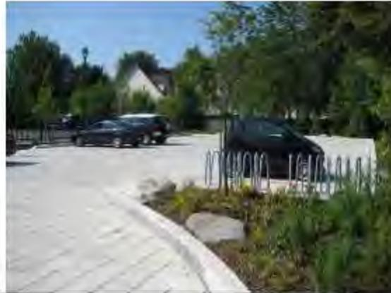
Le pavé drainant permet de réduire les coûts de drainage et la surcharge des eaux pluviales sur le réseau en plus d'offrir un meilleur indice de réflexion réduisant du même coup les îlots de chaleur;
