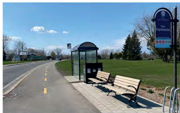
Arrêt d'autobus avec abribus et mobilier urbain
