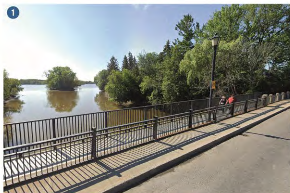
Fig.61 Passerelle piétonne annexée au Pont, Saint-Eustache © Google Street View
