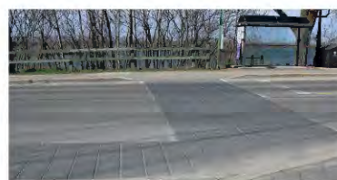
^ Marquage des traverses piétonnes
