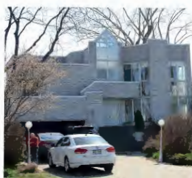
^ Maison unifamiliale de style international
