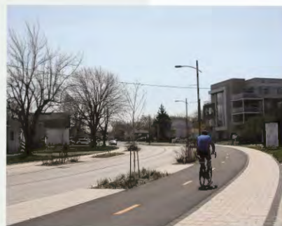
↗ Réaménagement de la piste cyclable sur la rue Centrale
