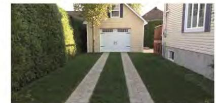
Fig.35. Bandes de roulement de béton © Pinterest
