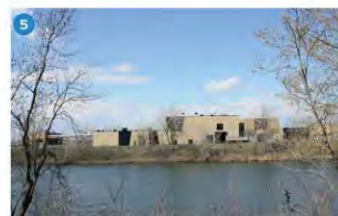
5 Usine de traitement des eaux
