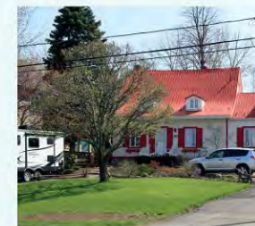
^ Maison à deux pans
