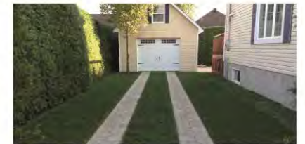
Fig.35. Bandes de roulement de béton © Pinterest
