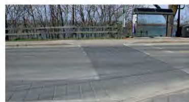
^ Marquage des traverses piétonnes
