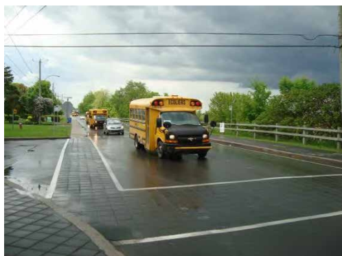
Traverse piétonnière avec pavage, intersection rue Jogues et boulevard Marie-Victorin
