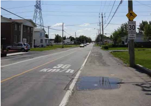
Marquage au sol, rue Brébeuf.
