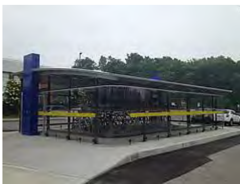
Vélostation de Deux-Montagnes, source : AMT.
