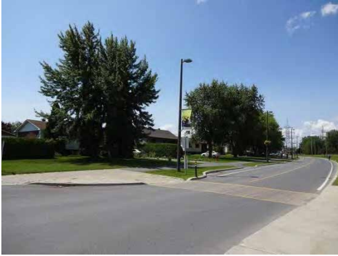
Avancée de trottoir et traverse piétonne, boulevard Saint-Laurent
