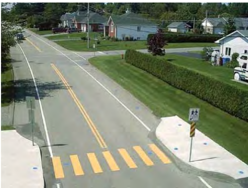
Exemple de marquage au sol d'un corridor scolaire, Ville de Sherbrooke, source : MTQ, Redécouvrir le chemin de l'école, Guide d'implantation de trajets scolaires favorisant les déplacements actifs et sécuritaires vers l'école primaire , 2009.
