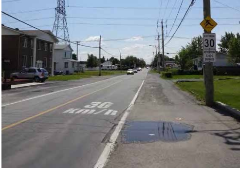
Marquage au sol, rue Brébeuf.
