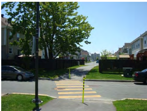
Traverse piétonnière avec balise latérale, promenade du Collège
