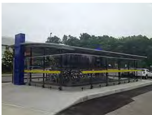
Vélostation de Deux-Montagnes, source : AMT.
