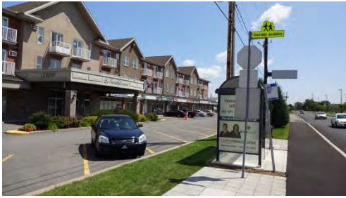
Résidence pour personnes âgées « Le Saint-Laurent », boulevard Saint-Laurent
