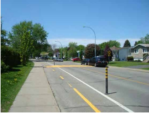
Dos d'âne allongé, rue des Marins
