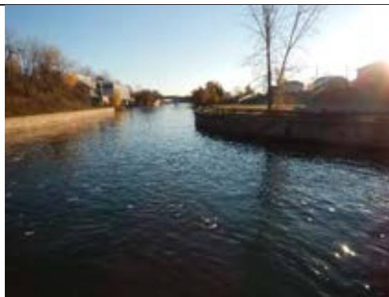
10 : Secteur de la voie maritime en aval du seuil
