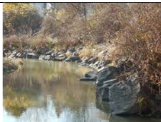
6 : Exemple de site jugé potentiel pour le lézardage (berge enrochée)
